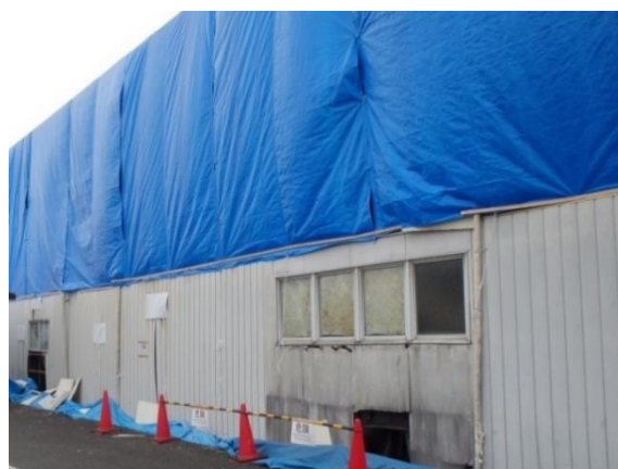
応急飛散防止措置の例 写真：熊本県
